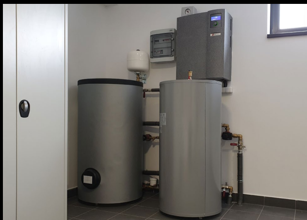
Hydraulický modul - HDV
