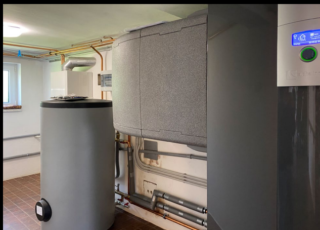
Vnitřní instalace vzduch/voda - LWCV 122
