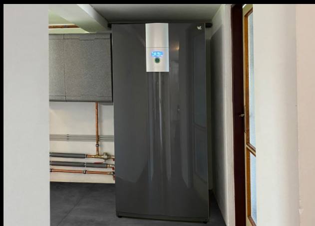
Vnitřní instalace vzduch/voda - LWCV 122
