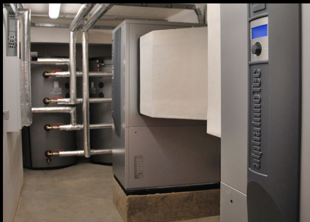
Vnitřní instalace vzduch/voda - 2x LW 251
